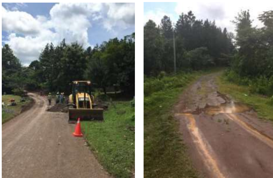
Figura 37 – Vistas de la infraestructura vial en el Distrito de Ñürüm
