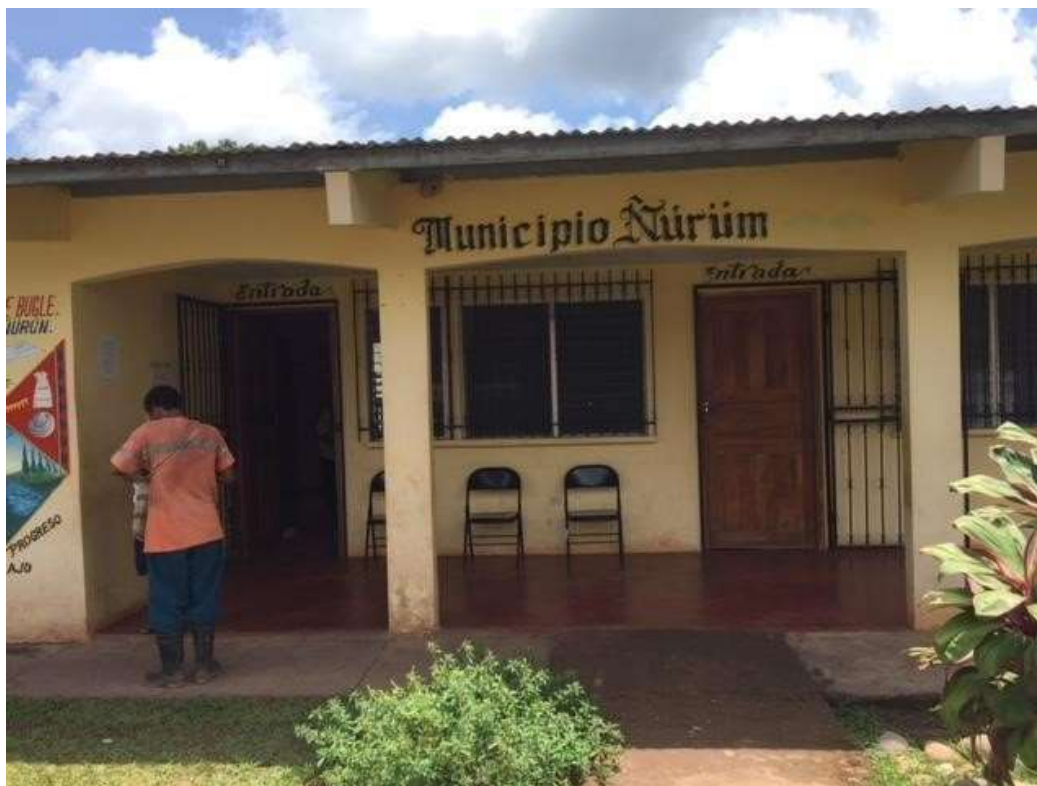
Figura 38 – Vista de las oficinas del Municipio de Nürüm
