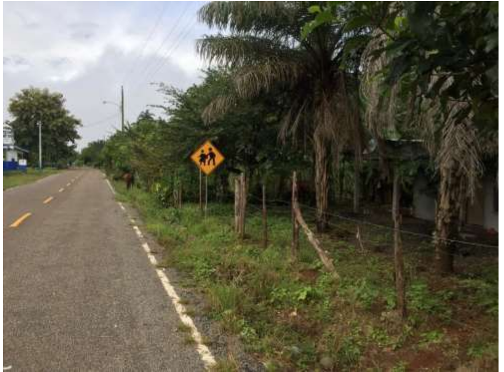
Figura 16 – Vista de la carretera camino a El Piro 1
